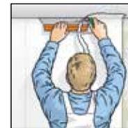
**5.** Enlever les excédents des plafonds, plinthes, fenêtres, etc. avec un cutter et une spatule.
