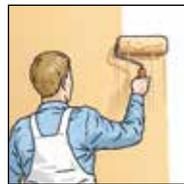
**7.** Après le séchage, recouvrir l'ingrain avec une peinture dispersion de qualité supérieure en conformité avec EN 13300.
