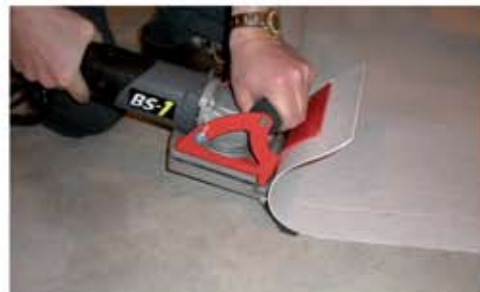
Dépose d'un lé PVC
