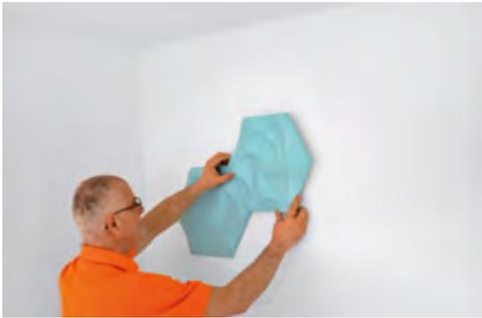
Monter les ARSTYL® WALL TILES bord à bord.
