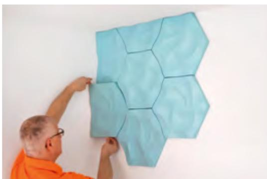
Jointoyer le raccord au mur et au plafond avec l'enduit adhésif ADEFIX®.
