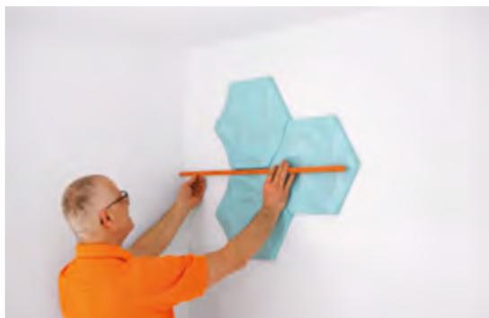
Mesurer le mur et déterminer la position des ARSTYL® WALL TILES. Ajuster la ligne de pose inférieure à l'aide du niveau à bulle.
