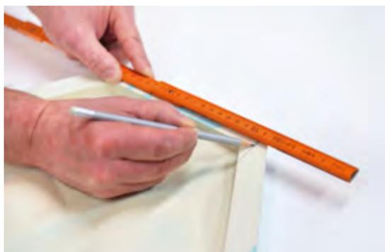
Mesurer les dimensions des ARSTYL® WALL TILES à adapter au niveau des raccords au mur et au plafond, puis les rapporter au dos des éléments.
