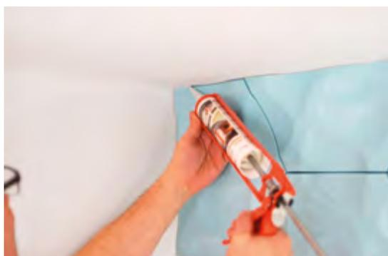
La face arrière des panneaux comporte des irrégularités et des creux. Si le panneau est monté de telle sorte qu'une face découpée reste visible, il est possible de l'enduire d'ADEFIX® PLUS et d'ADEFIX® pour la rendre lisse. ATTENTION: l'enduit de surface doit être ADEFIX® afin de garantir la bonne adhérence du revêtement de finition.
