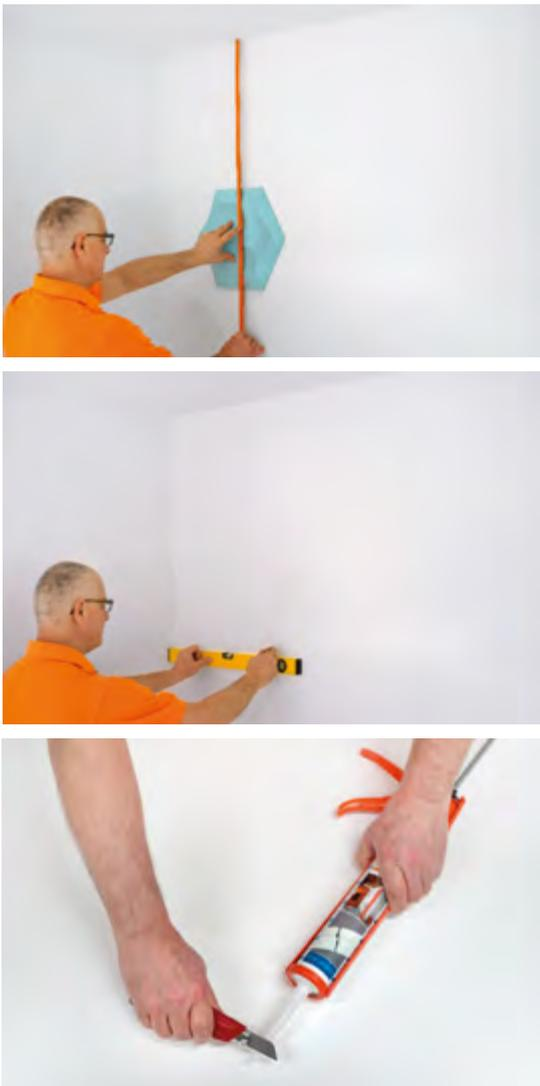
Mesurer le mur et déterminer la position des ARSTYL® WALL TILES.
