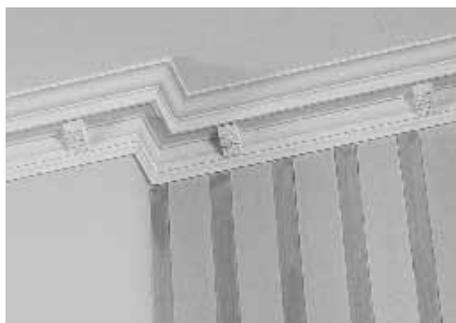
Réalisable uniquement avec la moulure Z24. Après avoir installé la moulure Z24, calculer l'espace nécessaire à l'installation de l'accessoire AC1 : la distance idéale est de 30 à 60 cm entre chaque élément. Coller avec la colle-enduit ADEFIX® P5. Après séchage (env. 2 à 8 heures), rejointoyer à nouveau avec la colle-enduit ADEFIX® P5. Après un temps de séchage de 24 h, passer à la phase peinture.
