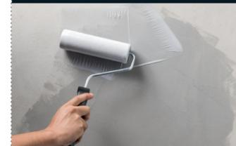
**1 - DÉPOSER** la matière avec le rouleau Liss PLANE<sup>®</sup> SYSTEM\*. Elle s'applique par zones successives de 0.5 m<sup>2</sup> de formes irrégulières. Il est important de croiser les gestes afin de ne pas avoir de démarcation. Appliquer de bas en haut pour éviter les coulures sur l'enduit parfaitement sec.
