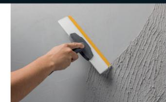
**5 - RATISSER** dans le frais avec le lisseur à lame Liss dure avec un angle fermé, les motifs créés en 1<sup>ère</sup> passe se révéleront ainsi. Pour un décor plus nuancé et doux au toucher, repasser délicatement sur l'enduit le lisseur à lame Liss dure afin de resserrer le grain.
