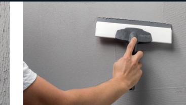
**3 - SURFACER.** Lisser dans le frais avec le lisseur à lame Liss souple, tout en laissant quelques côtes, coups de lames, vaguelettes.
