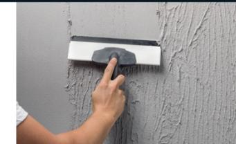
**2 - ÉGALISER.** Répartir la matière fraîche déposée avec le lisseur à lame crantée.
