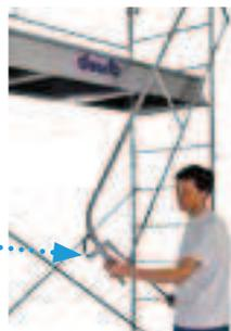
1 On insère le crochet du garde-corps dans l'orifice de la diagonale prévu pour le recevoir.
