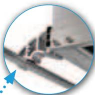
La position « montage » facilite, par légère inclinaison, le glissement horizontal des planchers sur les barreaux, en totale sécurité et sans forcer.
