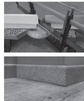
**ATTENTION :** le maintien de la plinthe doit être parfaitement perpendiculaire à la scie.
