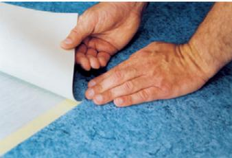
En cas de pose libre du revêtement PVC, c'est-à-dire s'il n'est pas totalement collé au sol, (merci de bien vouloir respecter les indications du fabricant du revêtement), il convient de fixer le joint au sol à l'aide d'une bande adhésive double face. Bien serrer l'une contre l'autre les bandes de revêtement PVC sur la bande adhésive double face.
