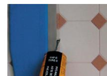
Souder les tapisseries PVC avec la garniture en alu. Retirer d'abord la bande plastique. Cette dernière sert au nettoyage de la garniture. Ajuster la garniture alu à plat et au centre du joint et appliquer de haut en bas et de façon régulière la pâte de soudure à froid PVC à l'aide d'une règle de peintre. Le volume de la pâte appliquée réduit d'environ 75 % lors du séchage ; ne pas essuyer, laisser simplement sécher (env. 30 minutes).
