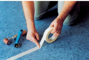
Nettoyer la zone du joint et appliquer une bande de papier cache adhésive **spéciale** résistante à notre liquide de soudure à froid sur le joint coupé. Ceci est absolument nécessaire pour éviter tout endommagement de la couche de surface (en polyuréthane par ex.) du revêtement.
