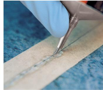
Au bout de 10 minutes environ, le liquide de soudure à froid sèche sur la bande adhésive et cette dernière peut être retirée en tirant de façon régulière en biais vers l'arrière. Les gonflements du revêtement PVC dans la zone du joint disparaissent. Le résultat : un joint à peine visible et très résistant. Vous pouvez marcher sur le joint après environ 30 minutes.
