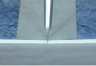
Le système à aiguille breveté pratique une petite ouverture dans la zone du joint, permettant ainsi au liquide de soudure à froid de s'écouler le long de l'aiguille et de se répandre dans toute la section transversale du joint. Les bords adjacents du revêtement sont ainsi humectés du liquide de soudure à froid, se soudent brièvement avant de fusionner l'un à l'autre de façon durable.
